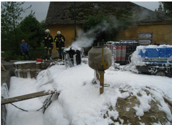
3. Mai: Kleinbrand bei Brückenbauarbeiten
